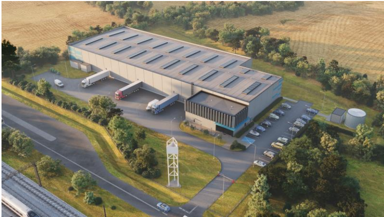
Hala magazynowa Chetm pow. 5 630 m 2 Termin realizacji 2026 r.
